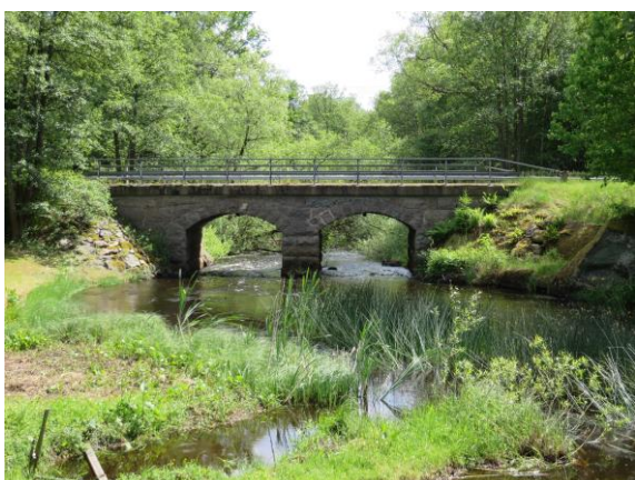
Stenvalvsbro med dubbla spann (1911) vid Knappsmålavägen. Man kan ana hur hög vattennivån var då det fanns luckor nedströms.
