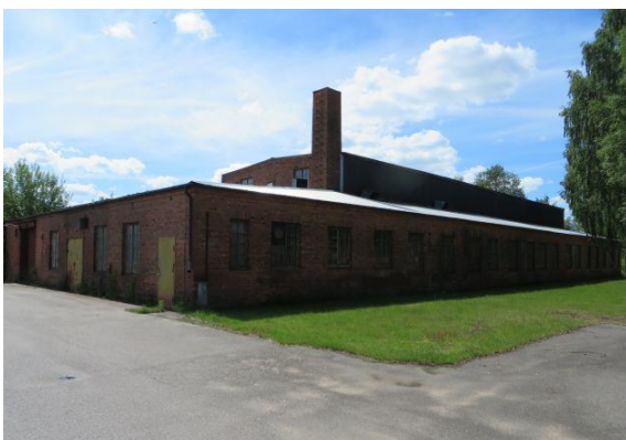
Emmabo 1:164, gamla gjuteribyggnaden på Tornborgs.
