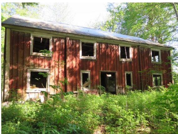
Emmabo 1:51, Lindboholm. En tvåvåningsbyggnad i förfallet skick, tidigare inrymmande bostäder, handelsbod och kontor.
