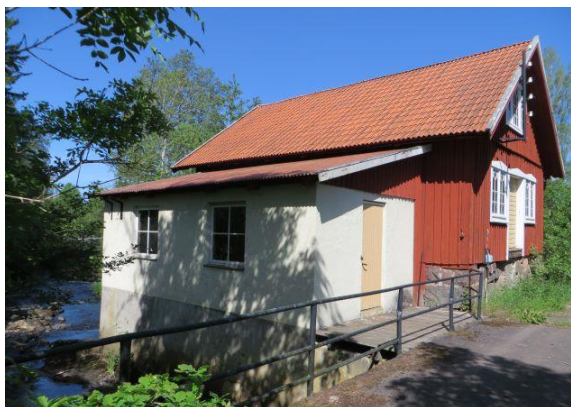
Emmabo 1:164, "Kulan" (1848). Kvarnbyggnaden är exteriört välbevarad och inrymmer ännu en gammal turbin och generator.
