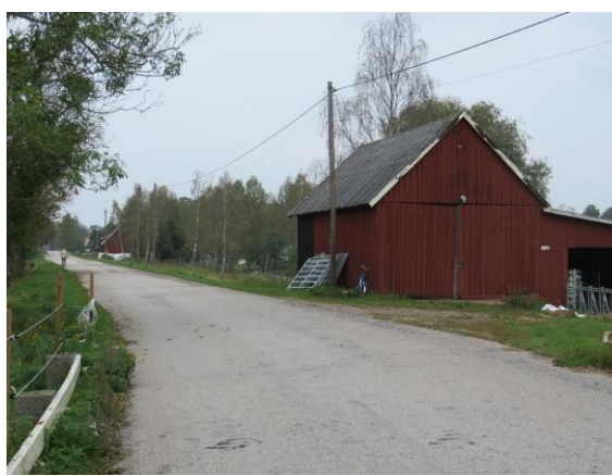
Emmabo 1:71, f.d. garage åt Vägförvaltningen.
