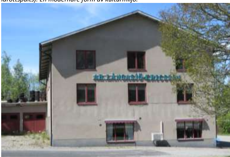
Långsjö-Erikssons verkstadsbyggnad har originaldelar och detaljer som den putsade fasaden, fönster och portar.
