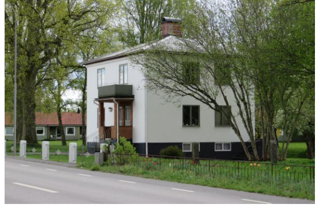
Ett välbevarat "funkishus" utmed Storgatan, Vissefjärda 1:57.
