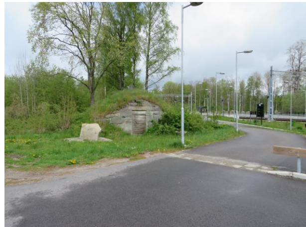
En stenkällare är det enda som finns kvar av den gamla stationsmiljön.
