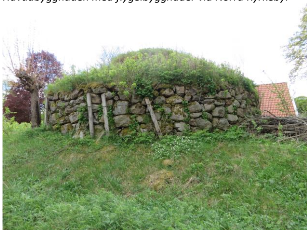
Vattencistern. Hit pumpades vatten från ån med hjälp av en vinddriven kvarn på taket.
