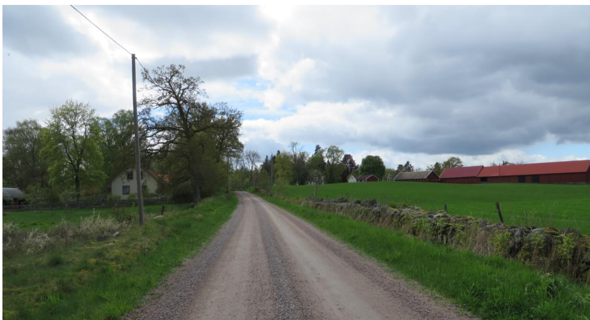
Norra Kyrkeby sett från byvägen, d.v.s. gamla landsvägen, norrifrån. Till vänster ses en av de arbetarbostäder som hör till miljön och på höger sida ses ekonomibyggnaderna som hör till gården
