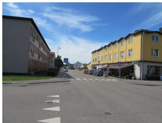
Tulpanen 12, tidstypiskt flerfamiljshus kallat "Miljonbygget" (1957).
