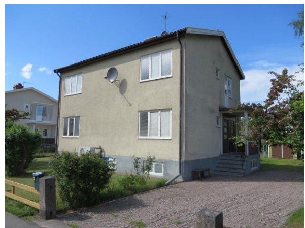
Järpen 8, huset har ett ursprungligt utförande.
