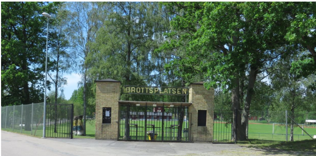
Idrottsplatsens värdiga entré från 1940-talet.
