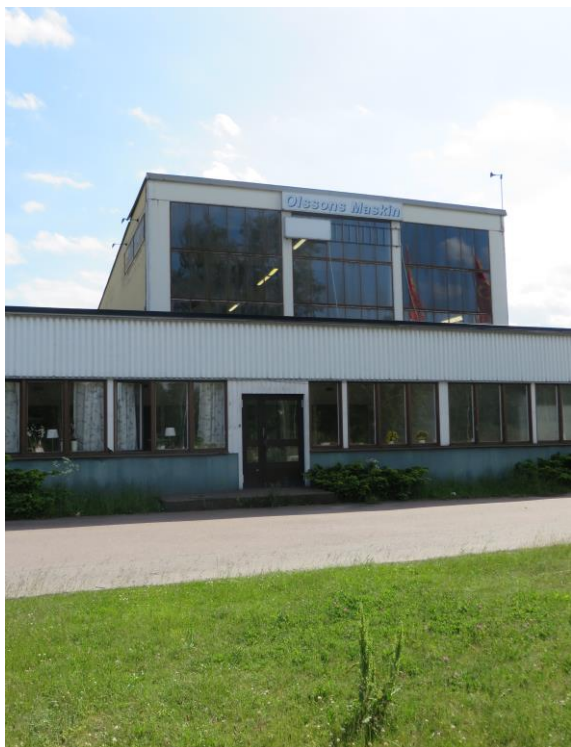
Spillkråkan 1, f.d. fordonshall vid Stenvägen.
