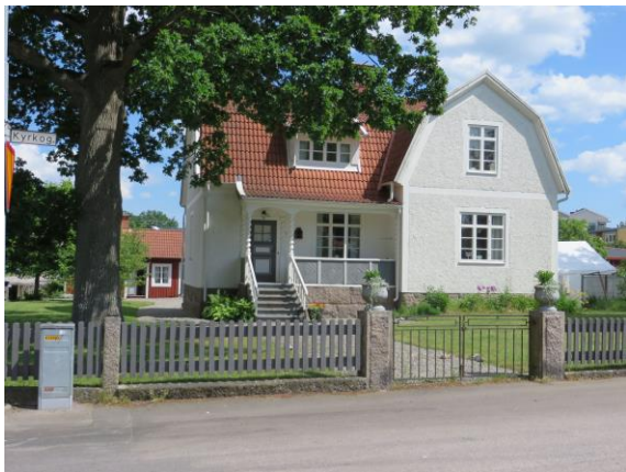
Aspen 12, tidstypiskt bostadshus (1920) och uthus. Verandan är försedd med karaktäristiskt vridna stolpar.
