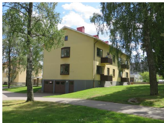
Kastanjen 8, flerfamiljshus vid Järnvägsgatan.
