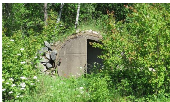
Emmabo 1:164, skyddsrum (1940-tal) på norra sidan av Tornborgsvägen.
