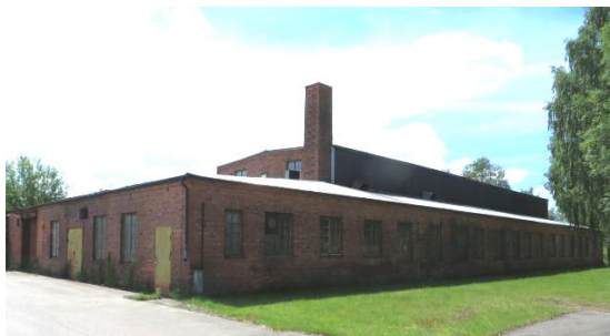
Emmabo 1:164, gamla gjuteribyggnaden på Tornborgs.
