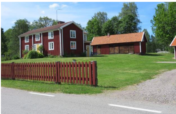
Emmabo 1:84, bostadshus (ca 1800-tal) med tillhörande uthus utmed Skutarydsvägen, "Almqvistska affären".
