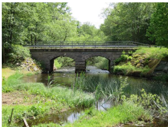
Stenvälsbro med dubbla spann (1911) vid Knappsmålavägen. Man kan ana hur hög vattennivån var då det fanns luckor nedströms.
