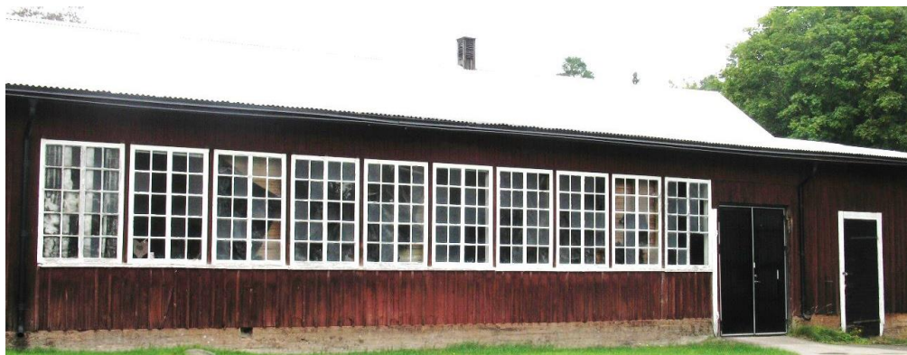
Det som idag är luffarmuseum var tidigare sliperi, vilket syns på de många fönstren.
