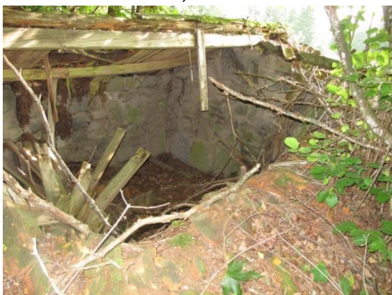
De två stenkällarna bakom bostadshuset har delvis inrasade tak, men kraftiga massiva stenväggar.
