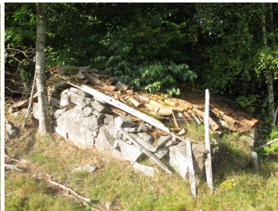
De två stenkällarna bakom bostadshuset har delvis inrasade tak, men kraftiga massiva stenväggar.
