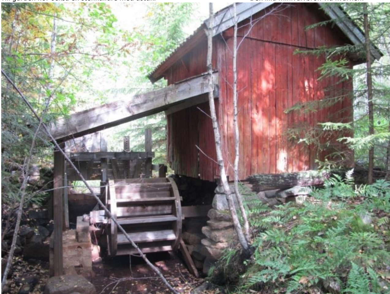
Karl-Roberts kvarnmiljö med liten hjulkvarn och handgrävd kvarndamm, Ubbemåla 1:5. Dammen finns kvar, men är torrlagd delar av året.
