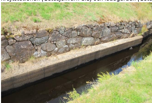
De äldre stensatta kanalerna finns kvar och har kompletterats med cementgjutna kanter på 1900-talet.
