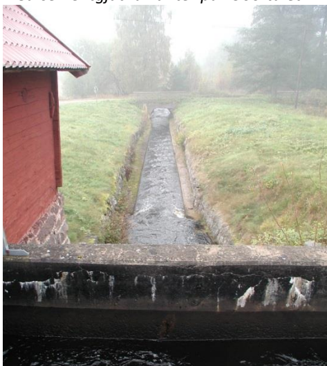
I utloppskanalen och bron finns både gjutna partier och delar av äldre stensatta partier. Bron precis söder om kraftstationen är valvslagen, men senare cementerad ovanpå.
