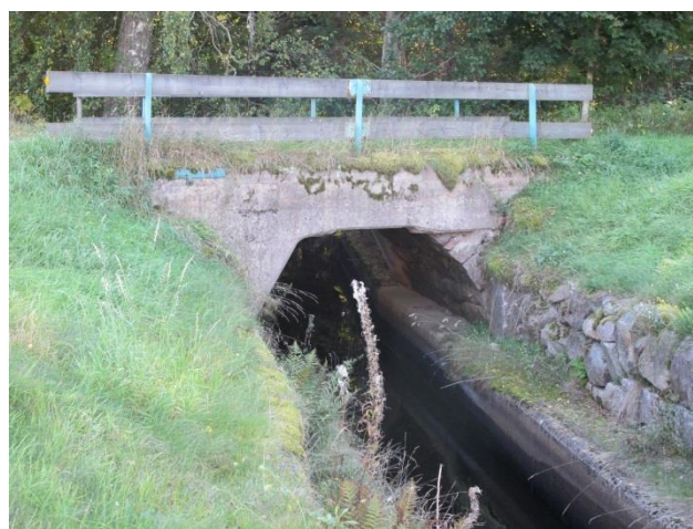
I utloppskanalen och bron finns både gjutna partier och delar av äldre stensatta partier. Bron precis söder om kraftstationen är valvslagen, men senare cementerad ovanpå.
