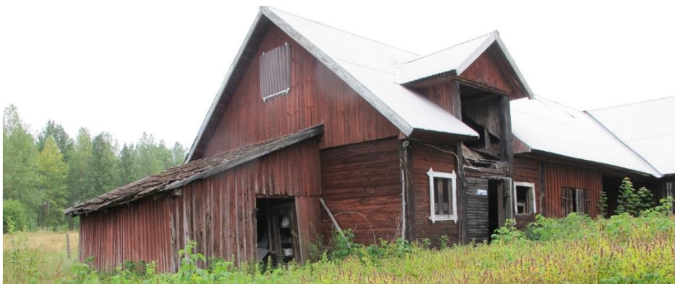
Ladugården på 1:5 byggd på traditionellt vis i skiftesverk.
