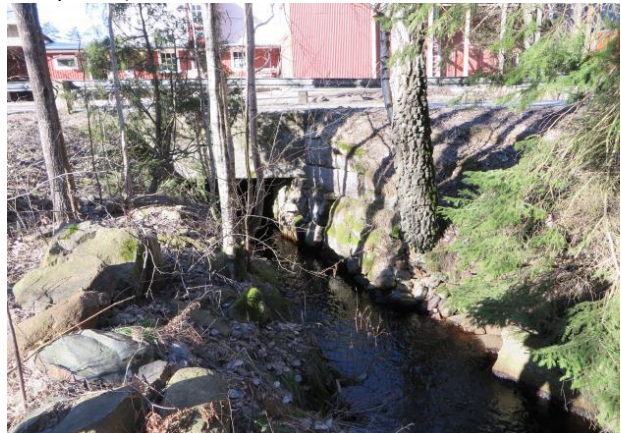
Den delvis stensatta utloppskanalen nedströms kvarnen.
