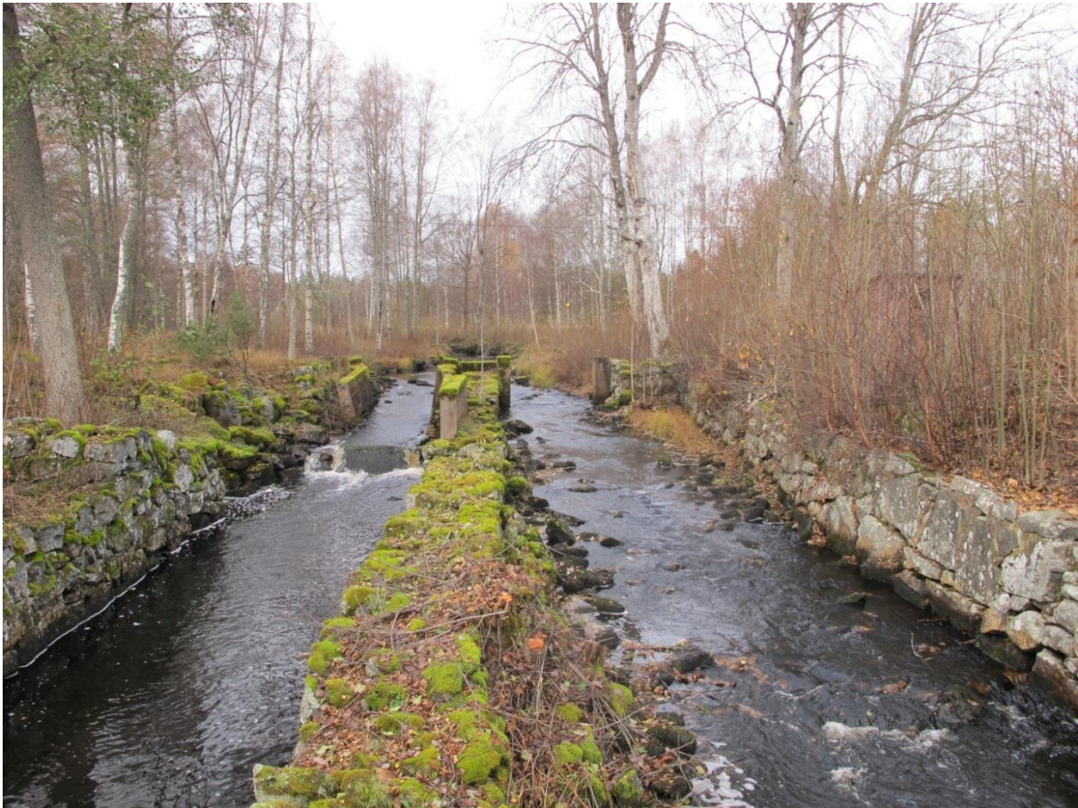
Stensatta vattenrännor (verkskanaler) i ån, väster om den södra bron. (Huvudhultakvarn 3:4)
