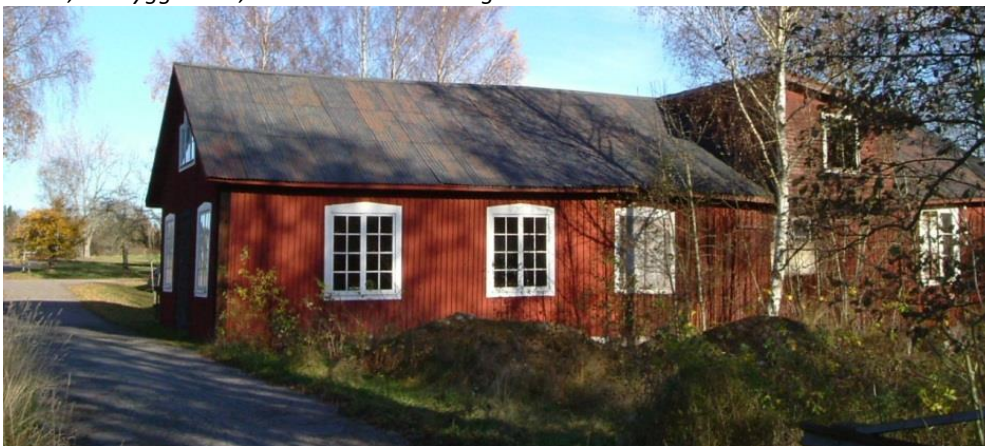
Gamla kraftstationen vid Stampadammen söder om glasbruket. (Johansfors 1:11)
