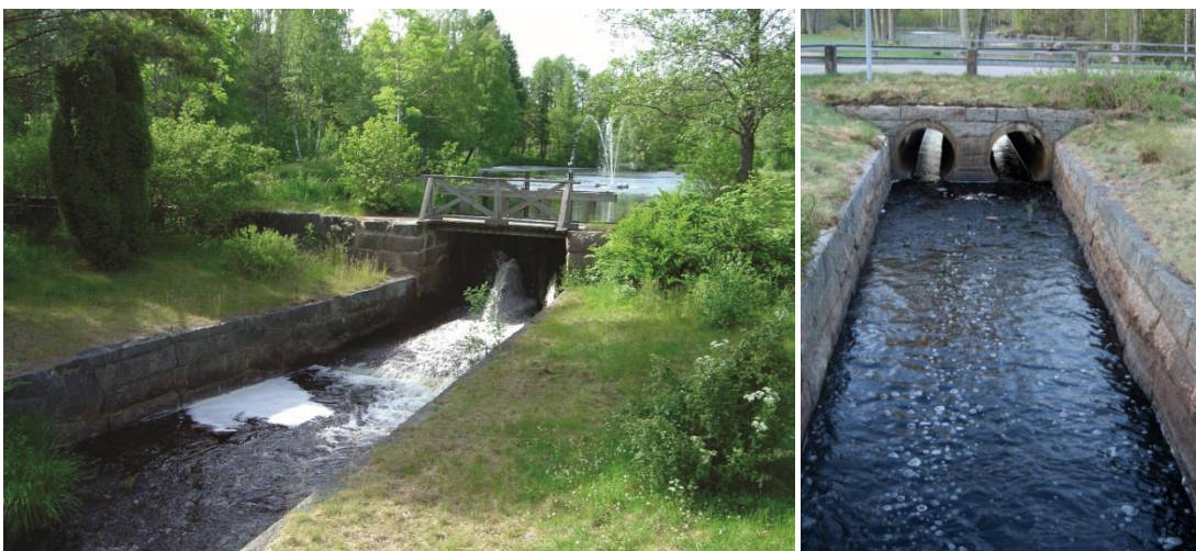
Stensatta vattenrännor, dammluckor och dammvallar i Johansfors. Här låg glasbrukets sliperbyggnader.
