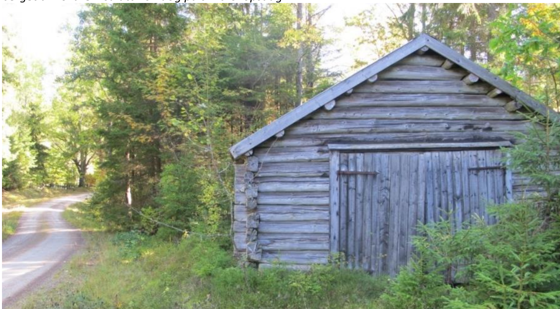
En av byns två bevarade ängslador (någon gång ombyggd till garage). (Suttaremåla 1:3).
