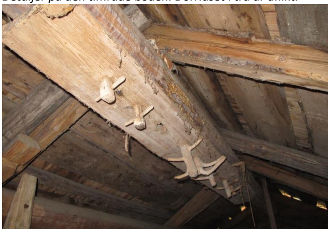
Krokar av grenar för förvaring på vinden. Taket är ett åstak.
