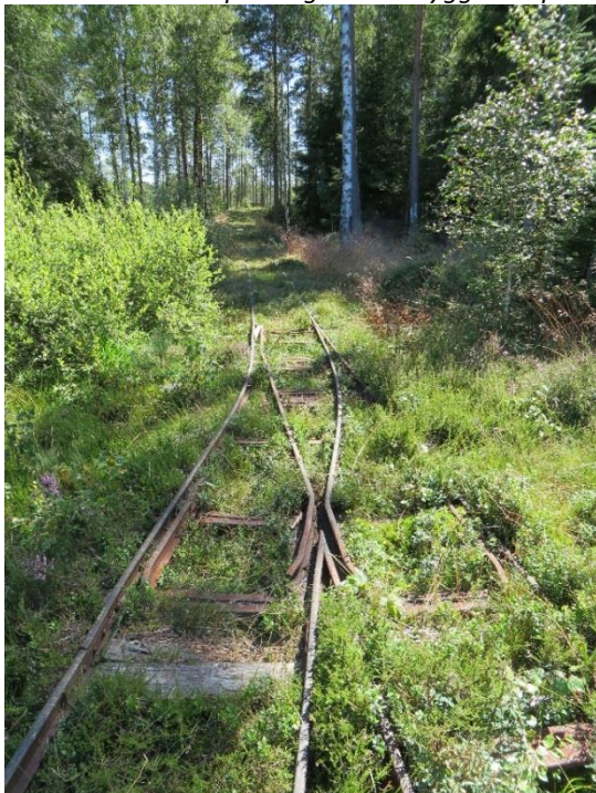
Mellan fält där torv grävs bildas smala upphöjda kanter som kan användas till torrskodd transportväg. Ibland byggs räls på dessa smala remsor.
