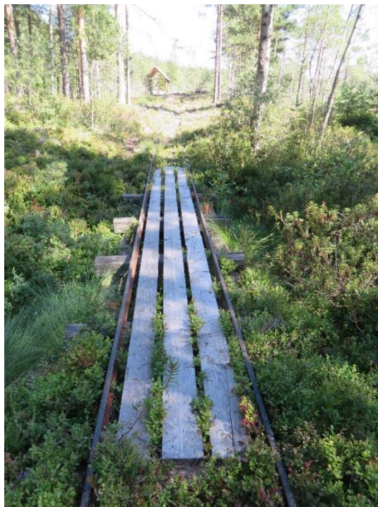
Mellan fält där torv grävs bildas smala upphöjda kanter som kan användas till torrskodd transportväg. Ibland byggs räls på dessa smala remsor.
