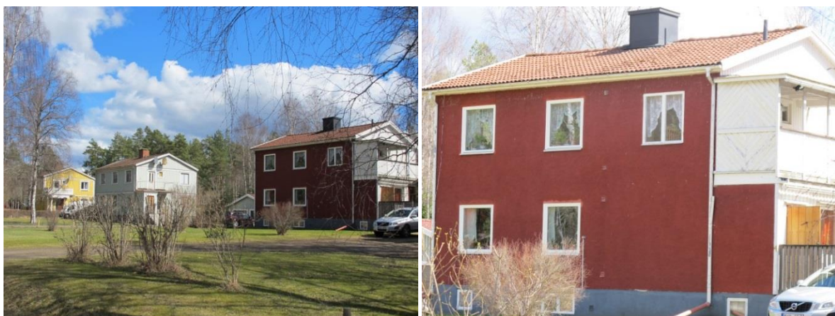
Funkisvillorna i "Hollywood". (Ålgärdehult 1:62, 1:63 och 1:64). Det röda huset är det enda röda med originalputs.
