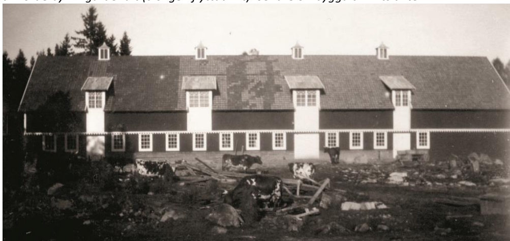
Ladugården från mitten av 1920-talet är till stora delar välbevarad. Man kan också se hur den byggts till med en större loge (1930).
