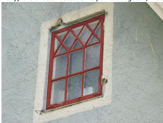
Detalj av äldre fönster.
