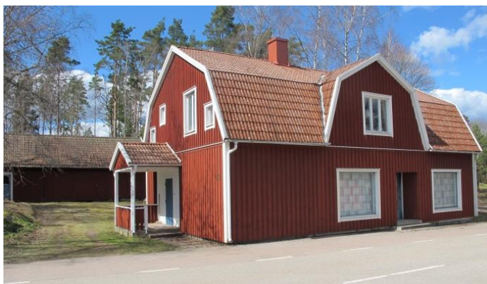
F.d. brukshandeln (Ålgärdehult 1:54) med bevarat uthus/magasin.
