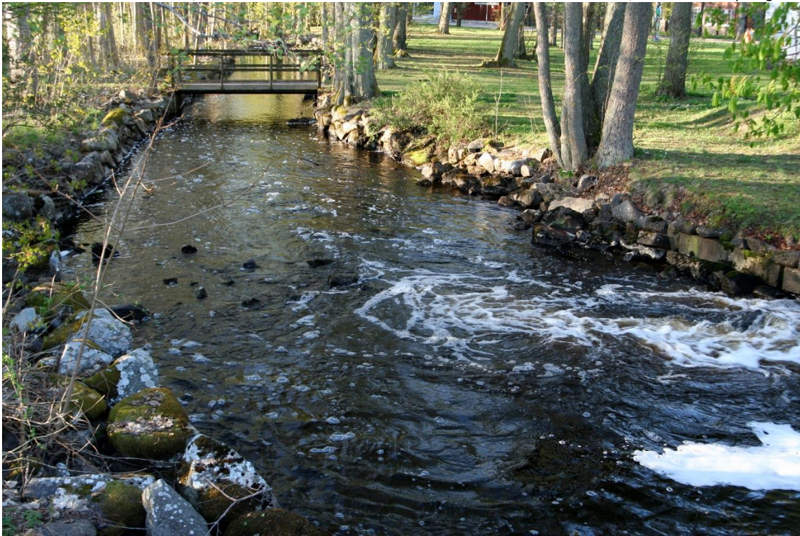
En av två åfåror som användes för uttag av vattenkraft vid glasbrukets sliperi, som låg till vänster i bild.
