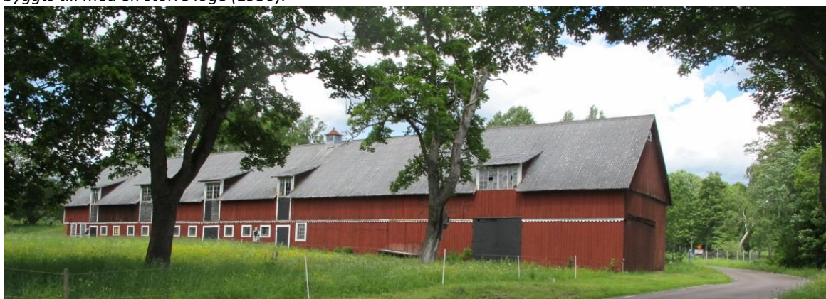
Ladugårdens tak har täckts med eternit i stället för tegel och fönstren på bottenvåningen har bytts.
