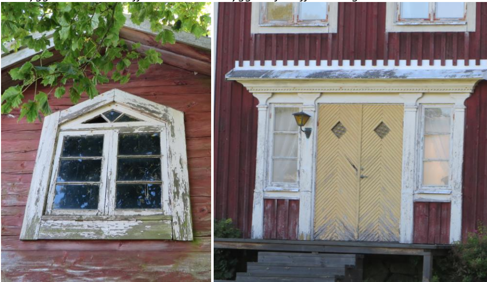
Fönster i den gamla källarboden samt dörrpartiet på huvudbyggnaden (Allgunås 3:3).
