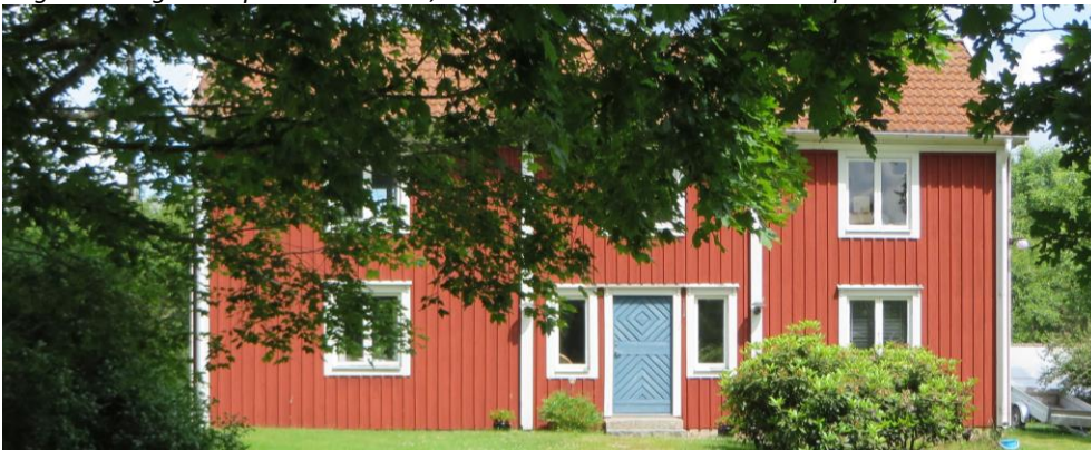
Denna gård centralt i norra delen av byn är idag frånstyckad (Allgunås 2:18) och utan ladugård. Bostadshuset är en rödmålad traditionell parstuga i två våningar, som genomgått renoveringar under 1900-talet där delar av originaldetaljerna bytts ut.
