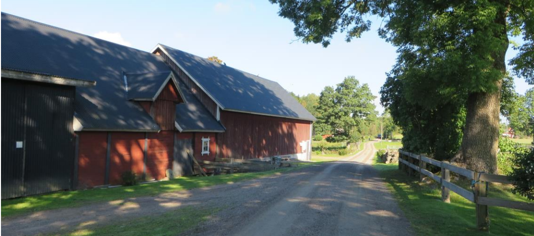
Södra gården (Allgunås 3:3) med ladugården på andra sidan vägen.
