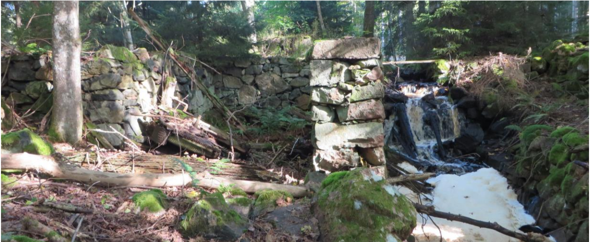
Ruinen efter en av Allgunås kvarnar. Till miljön hör även en grävd kanal, en dammbank, damm och grunderna efter mjölnarbostaden, i form av stugans grund och bevarade stenväggar från en jordkällare.
