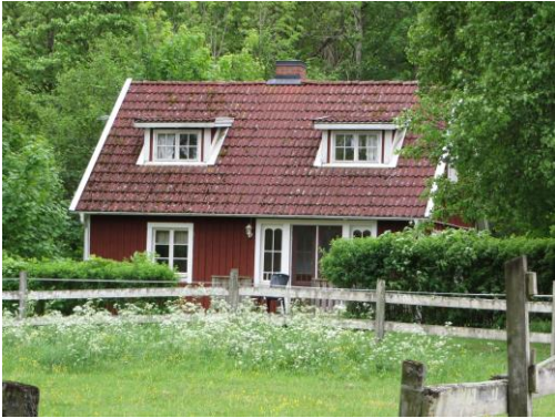
Till gårdsmiljön på Ekeboryd 1:3 hör även det ombyggda inredda f.d. undantagshuset.
