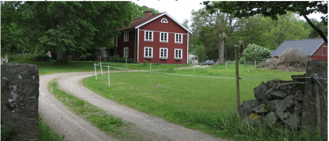
Bostadshuset på Ekeboryd 1:3 är en ovanligt stor mangårdsbyggnad.
