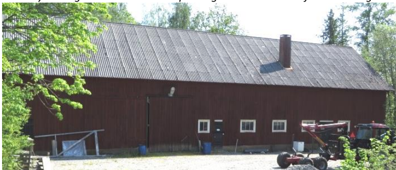
Ladugården som hör till är uppförd 1952 (Enkoneryd 1:9).
