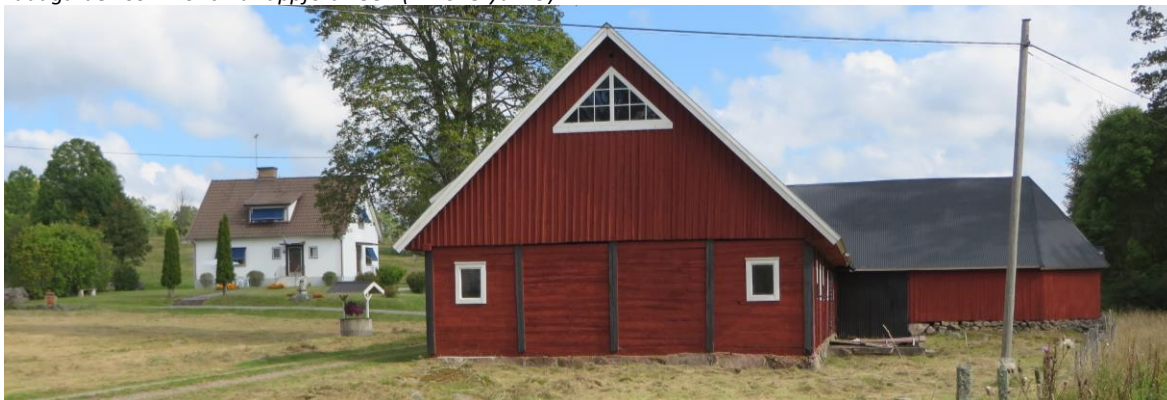
En av byns fyra gårdar fick nytt bostadshus 1952 (Enkoneryd 1:4). Ladugården är däremot byns äldsta. Den har också bevarad inbyggd tröskloge på baksidan, och har sammantaget högt kulturhistoriskt värde i sig.
