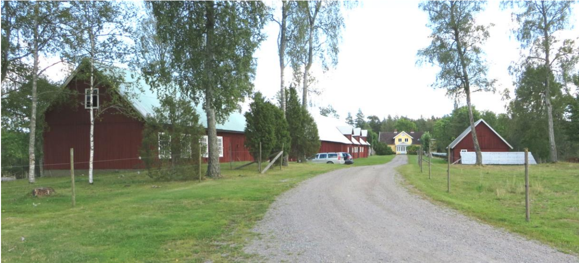
Gården Hamburg sedd från gamla byvägen från Bredalycke. Från vänster ses hönsbush, ladugård, snickarverkstad (dold), mangårdsbyggnaden, stenkällaren (dold), stallet och ytterligare en stenkällare. Till vänster utanför bild ligger linbastan.
