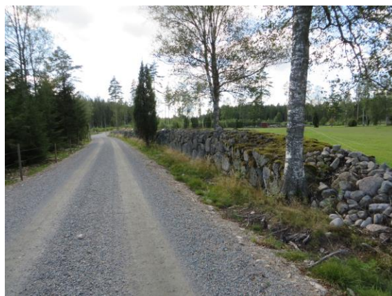
Den nya vägdragningen har i huvudsak förlagts utmed åkerrenar i landskapet.
