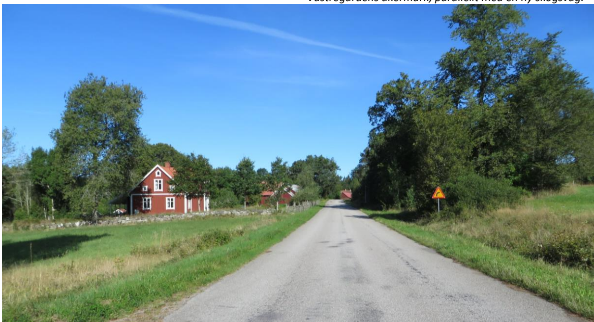
Den östra bykärnan sedd söderifrån. Närmast ses en av de utflyttade gårdarna, Ingemundebo 1:34.
