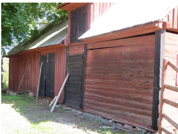
Denna lilla ålderdomliga lada byggd i skiftesverk ligger öster om vägen och på två fastigheter (Lida 2:15 och 2:20).
