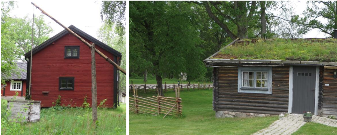
Utemiljön runt vandrarhemmet har kompletterats med brunnskar och ålderdomlig brunnsvinge samt trädgårdesgård. Brygghuset stod tidigare vid prästgården.
