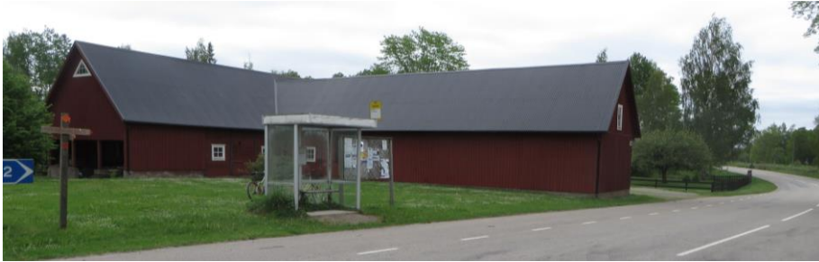
En av få ladugårdar som finns kvar vid gamla vägskälet i gamla bondbyn. Byggnad med en äldre del i skifteverk och nyare delar från 1900-talet.
