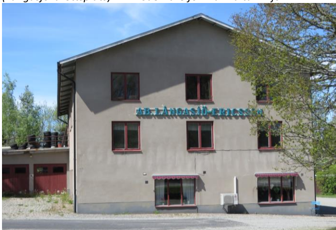
Långasjö-Erikssons verkstadsbyggnad har originaldelar och detaljer som den putsade fasaden, fönster och portar.
