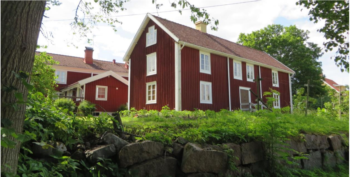
Två av de tre mangårdsbyggnaderna som ligger centralt i den gamla bykärnan (Rammsjö 1:20 och 1:19).
