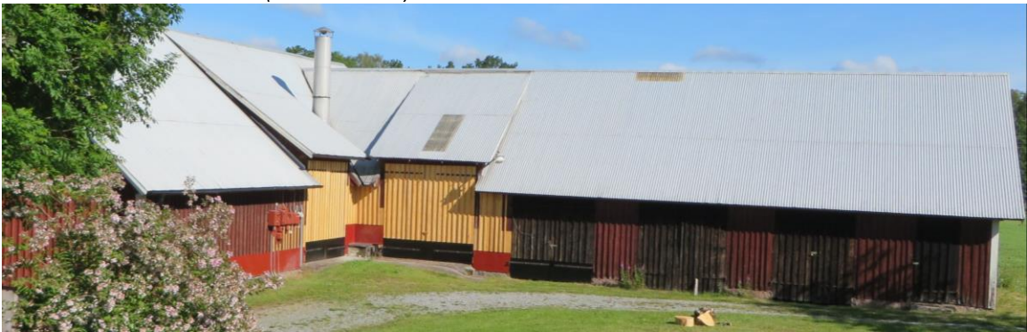
Ladugården (Runnamåla 3:6) är byggd av panelklädd regelstomme och har traditionell färgsättning.
