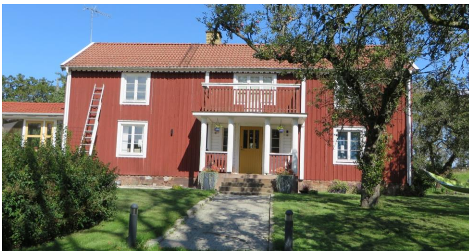
Mangårdsbyggnaden en traditionell faluröd parstuga som påverkats av olika sorters renoveringar och tillbyggnader (Skurebo 2:3). Den kan dock vara byns enda byggnad som ligger kvar på samma plats som före laga skifte (1831), se kartöverlägg ovan.
