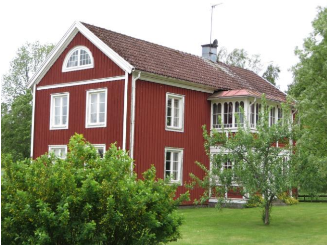
Fönster i gavelpartier och dubbel glasveranda ger karaktär åt denna mangårdsbyggnad (Strängsmåla 1:12).
