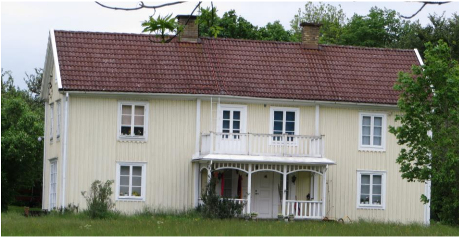
Mangårdsbyggnad med hyvlad ljus träpanel (Strängsmåla 1:24).
