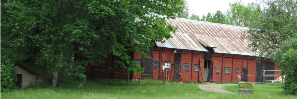
Tillhörande traditionell ladugård byggd i skiftesverk (Strängsmåla 1:24).
