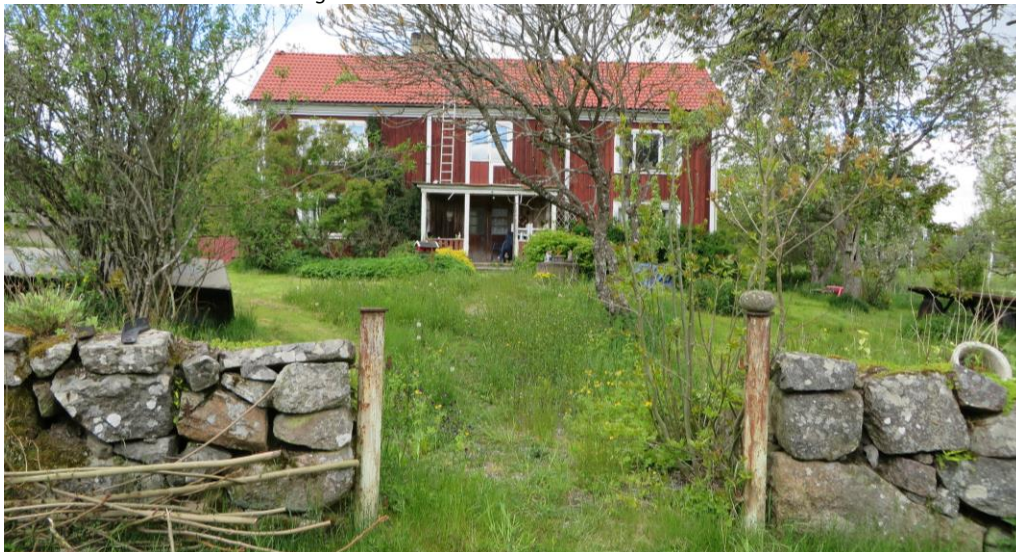
Denna gård söder om Kalmarvägen är byns enda parstuga (1852), renoverad och ombyggd på 1950-talet. Staket, grindhål och trädgård är också en viktig del av gårdens karaktär (Björnabygden 1:4).
