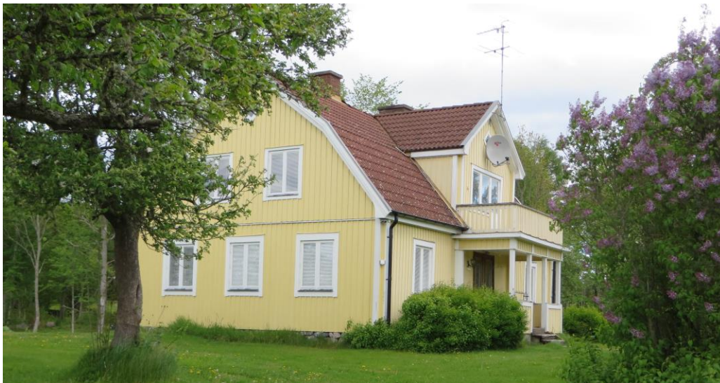
Den andra gården norr om Kalmarvägen har en äldre mangårdsbyggnad (1869) som renoverats på 1950-talet, då alla yttre ytor, material och detaljer bytts mot nya (Björnabygden 1:6).
