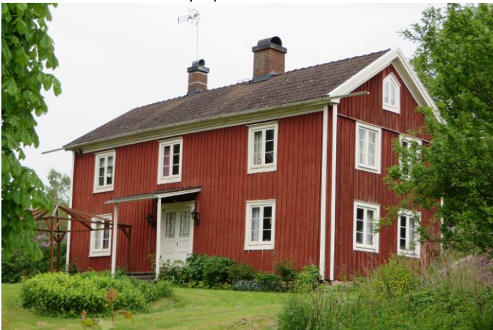
Den gamla mangårdsbyggnaden på Bredasjö 2:3 har kvar många originaldelar och material. Inte minst den äldre panelen och ursprungliga fönster ger karaktär åt byggnaden.
