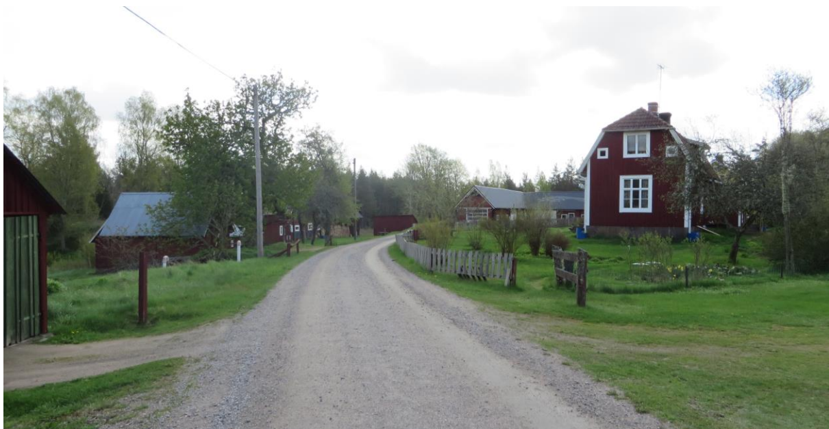
Byvägen slingrar sig tätt intill bebyggelsen i bykärnan. Bromboda 1:21 är en välbevarad gårdsmiljö med byggnader från cirka 1880 – 1940-talet.
