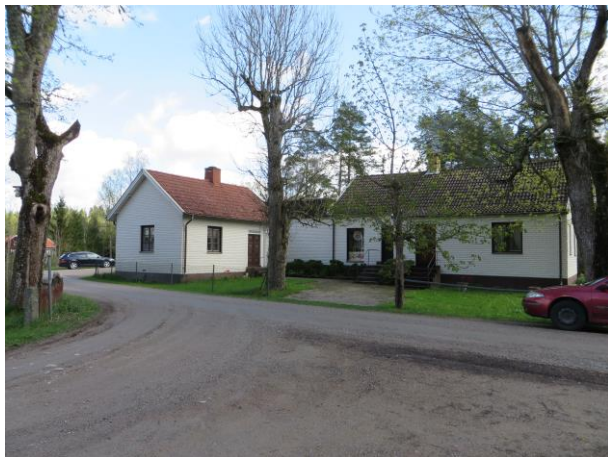
Lanthandeln i Bromboda är uppförd 1890, Bromboda 1:13. Huset till vänster är troligen äldre.
