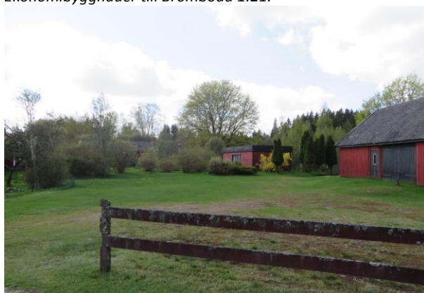
Mangårdsbyggnaden till Bromboda 1:19 bär tydliga spår efter en sentida renovering.
