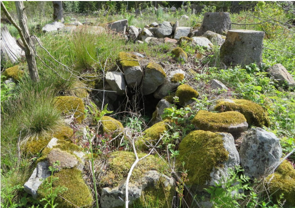
Den bygemensamma bråttugnen (linugnen), med en bevarad ovanlig valvslagen ugn.
