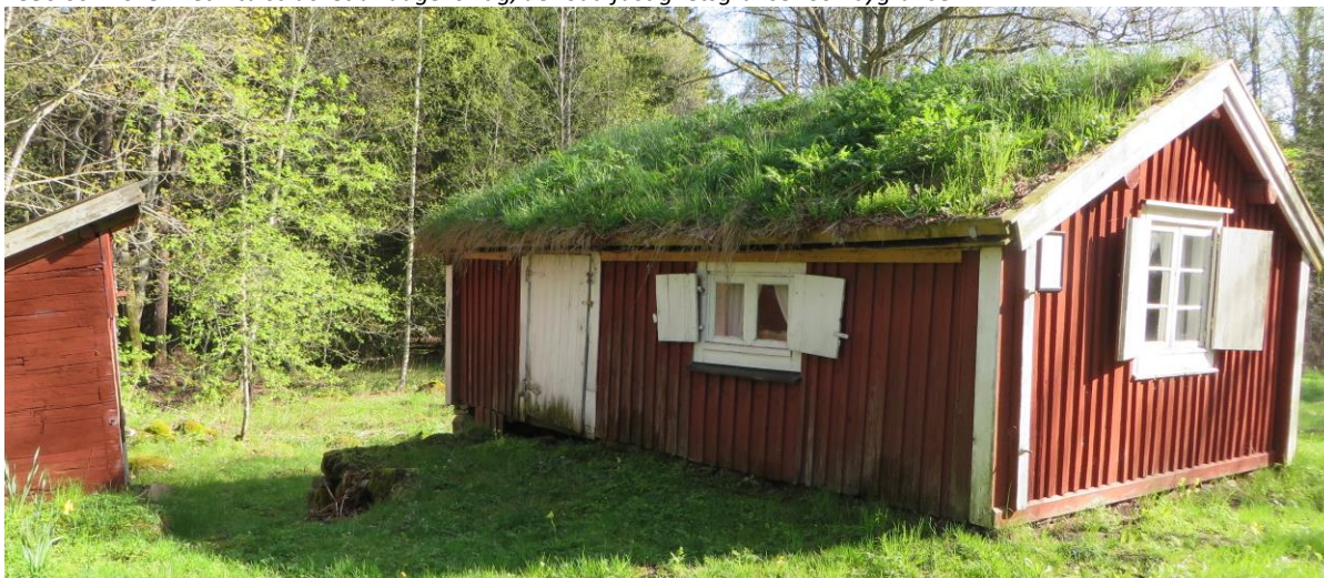
Även om torpet genomgått flera stora renoveringar och majoriteten av ytor och detaljer exteriört har bytts ut mot nya, så har stugan en ålderdomlig karaktär och ett stort pedagogiskt värde.
