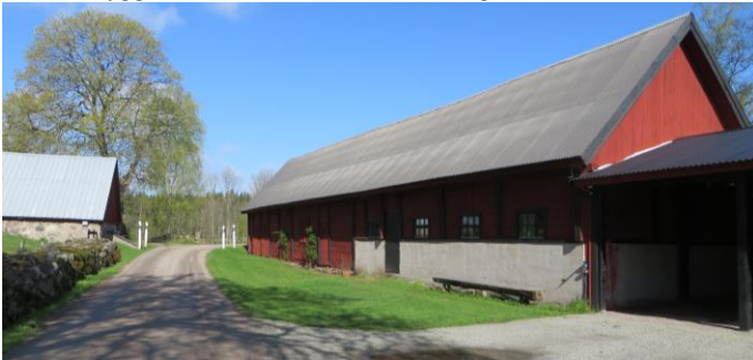
Ladugården är delvis byggd i traditionellt skiftesverk, troligen uppförd ca 1850 (Djuramåla 1:4).
