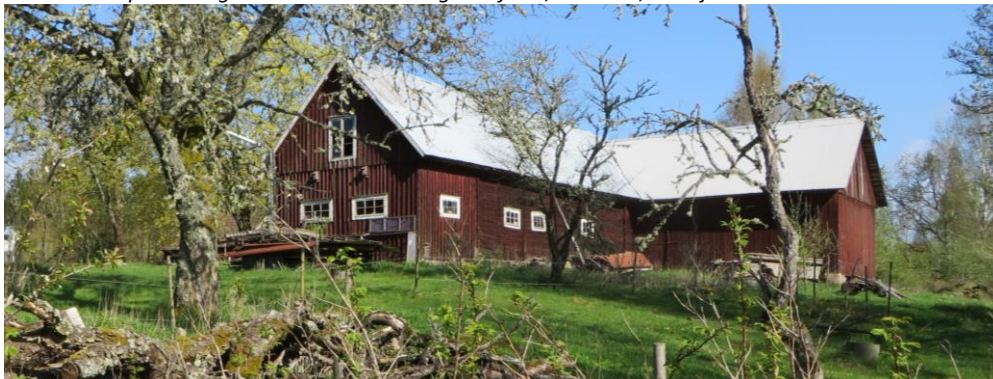
Ladugården som hör till gården Djuramåla 1:3 är en traditionell välbevarad ladugård i skiftesverk, enligt uppgift 8 uppförd kring 1865.
