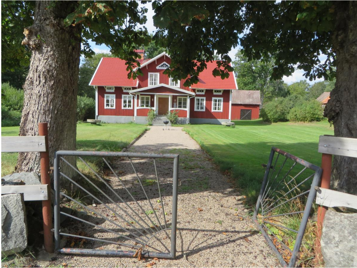
Gården Eremitemåla 1:24 har flera kulturhistoriskt intressanta ekonomibyggnader, där några bildar en egen enhet, en ladugårdsplan, vid sidan av mangårdstomten.
