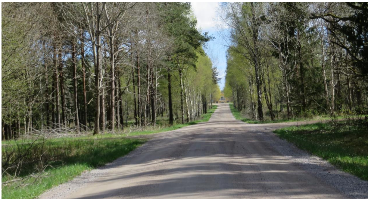
Den raka infartsvägen till gården Flädingstorp från väg 28 har troligen tillkommit under 1900-talets första hälft. Vägen som ses korsa infarten är landsvägens gamla sträckning.
