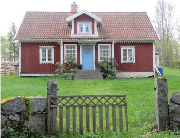
Förlångsö 1:13. Äldre ombyggt bostadshus, utan yttre originaldetaljer.
