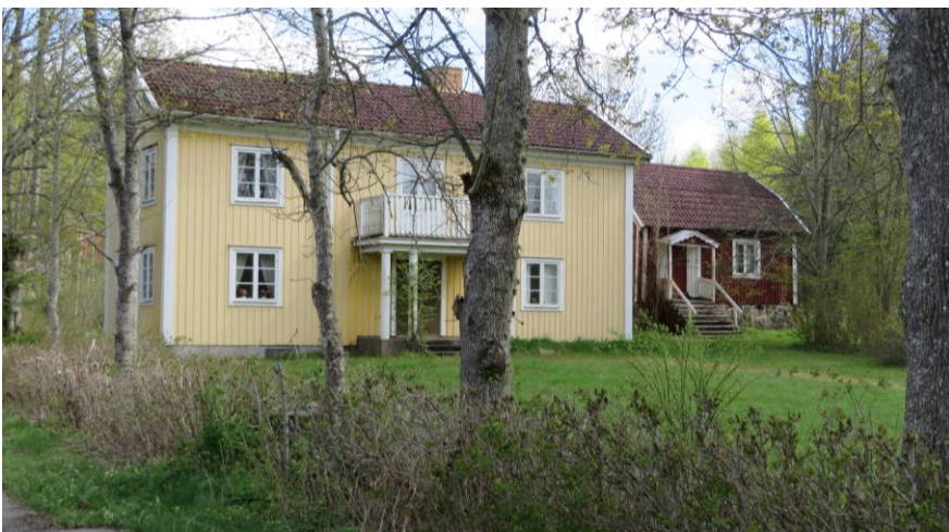
Förlångsö 1:5. Huset har kvar delar av sin grundform, men har också påverkats av en 1950-talsrenovering. Undantagshuset är mer orört.
