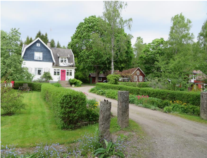
Förlångsö 1:31. Bostadshus i 1920-talsstil, senare ombyggd, och ett för miljön viktigt uthus. Denna byggdes av handlarens son Richard, som också blev delägare i sågen. Trädgården är enligt uppgift arkitektritad, vilket tillhör ovanligheterna i kommunen. Hustrun Ellen ska ha vävt åt Kalmar hemslöjd.
