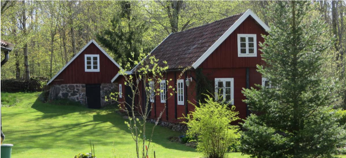
Stor stenkällare, eller källarbyggnad, och uthus i traditionellt skiftesverk (Hulan 1:8).
