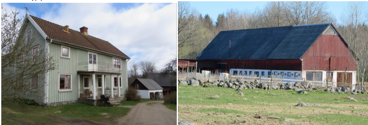
På Karamåla 3:2 finns den enda av de äldre mangårdsbyggnaderna i byn som inte är rödfärgad. Färgsättningen hänger säkert samman med byte av panel, eller panelning av timmerhus, i slutet av 1800-talet. Den släta hyvlade panelen målades med linoljefärg i stället för röd slamfärg (Falu rödfärg). Ladugården till Karamåla 3:2 uppfördes på 1950-talet och är därmed exempel på kontinuitet. Den är större än äldre skiftesverksladugårdar och tillbyggd med ytterligare en tredjedel i slutet av 1900-talet.
