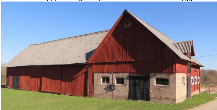
Ladugård och loge till Karamåla 2:4. Ladugårdsdelen har moderniserats, vilket kan ses som exempel på lång kontinuitet.
