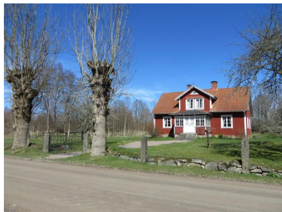
Välbevarad mangårdsbyggnad i Västra Klippingsbo, Klippingsbo 3:23.
