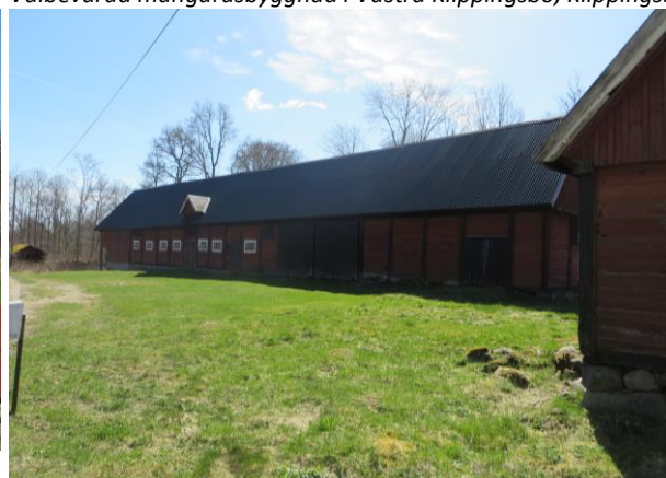
Till gårdsmiljön hör en ladugård i skiftesverk, Klippingsbo 3:3.
