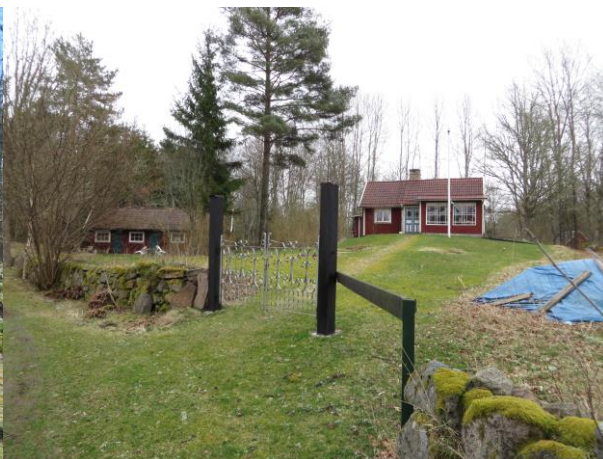
Utmed vägen som går norr om Västra Klippingsbo gamla hustomt ligger tre mindre gårdar med mangårdsbyggnader och tillhörande ekonomibyggnader. Här ses Klippingsbo 3:8.
