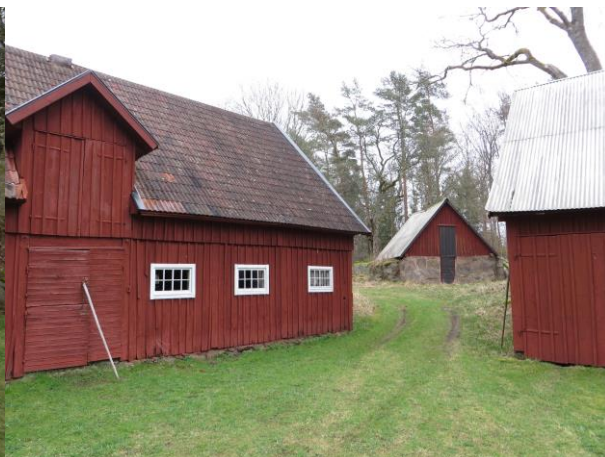
Vid torpet "Nyströms" finns förutom bostadshuset även ekonomibyggnaderna och en källarbod bevarade.
