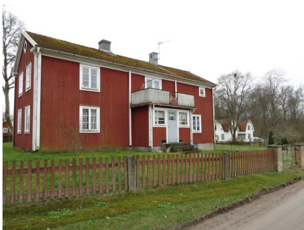
Mangårdsbyggnaden på Klippingsbo 1:14 är en parstuga som ligger i samma läge som ett tidigare bostadshus.
