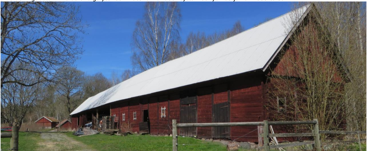
Ladugården är uppförd i traditionellt skiftesverk (Lekaremåla 1:2).
