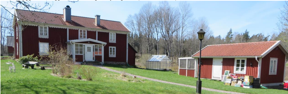
Den norra mangårdsbyggnaden (Lekaremåla 1:7) har kvar den ursprungliga formen av en hög smal tvåvånings parstuga och färgskalan med de faluröda väggarna. De två skorstenarna sitter i äldre läge mitt på takfallet, vilket skvallrar om ett ålderdomligt åstak. Alla utvändiga ytor och material har dock bytts mot nya i början av 2000-talet.
