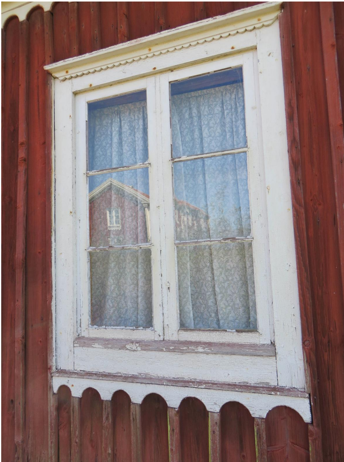
Undantagshuset har kvar alla originalfönster, byggda med hög kvalitet i virke, detaljer och hantverksutförande. De handblåsta glastrutorna ger en traditionell och vacker lyster.
