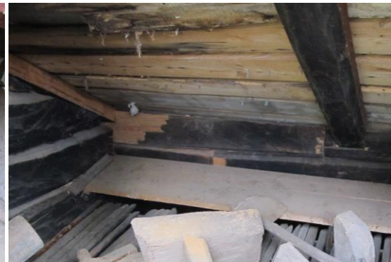
Den lilla rökugnen ligger under byggnaden. Väggar och takstolar finns kvar från tiden då den användes.
