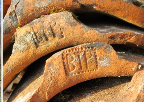
En källarbyggand och ett bryggghus med invändig brunn finns vid gården (Lekaremåla 1:2). På ladugårdens tak har legat handslaget lertegel från BTP= Bruatorps tegelbruk i Söderåkra (1700-tal till tidigt 1900-tal).
