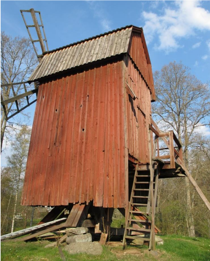
I ängsmarkerna mellan gården och ån ligger en vädervärd på en kulle. Kvarnen är en s.k. stubbkvarn av samma typ som finns på Öland, och är unik för kommunen. Det är ovanligt att gammal väggpanel finns kvar, vilket är av kulturhistoriskt intresse (Lekaremåla 1:2).
