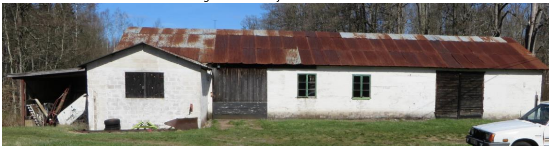
Sågverket lokaliserades hit då det startade på 1950-talet tack vare närheten till stationen.
