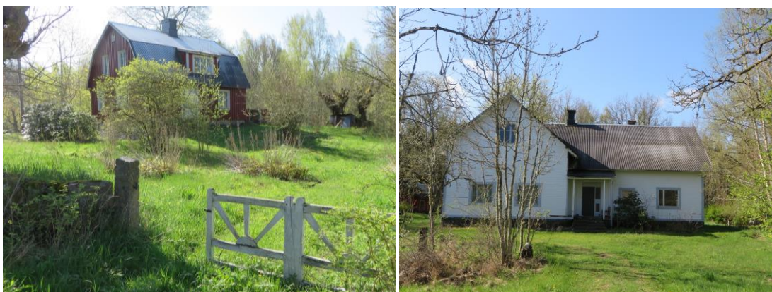
Stolpabäck 1:23 och gamla skolan. Den har påverkat många barns liv, och är bärare av många minnen, eller ett kollektivt minne. På så sätt har den ett kulturhistoriskt värde, även om byggnaden förändrats. Tillhörande utedass är också viktigt i en skolmiljö (Stolpabäck 1:22).
