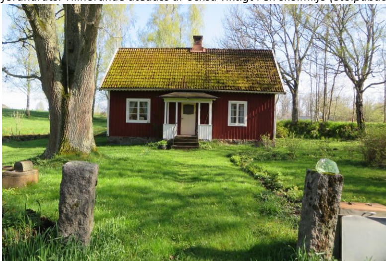
Stolpabäck 1:21, ett av byns ställen som inte var en egen gård, utan där ägaren försörjde sig på andra sätt, t.ex. med hantverk. Här bodde en period snickaren Viktor, med hustru Hilda, fyra barn och svärmor Cajs. Hus från tidigt 1900-tal, troligen delvis ombyggt på 1940-talet.
