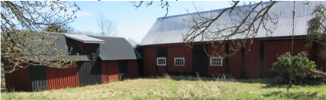
Uthus och ladugård som hör till gamla Södergården.
