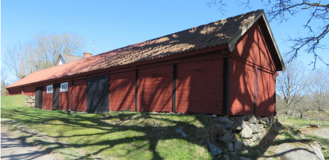
Det gamla svinhuset med potatiskällare och vedbodar.
