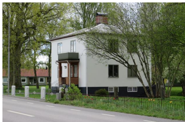
Ett välbevarat "funkishus" utmed Storgatan, Vissefjärda 1:57.
