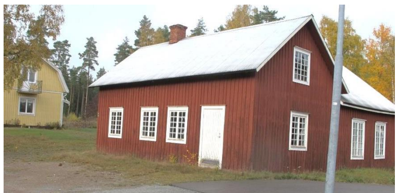
Bröderna Alfredssons cykelverkstad, föregångaren till Fröjd motor. Långelycke 1:33. Balkongen pryds med årtalet 1924, troligen tillverkat av en lokal smed, se bild med detalj under.
