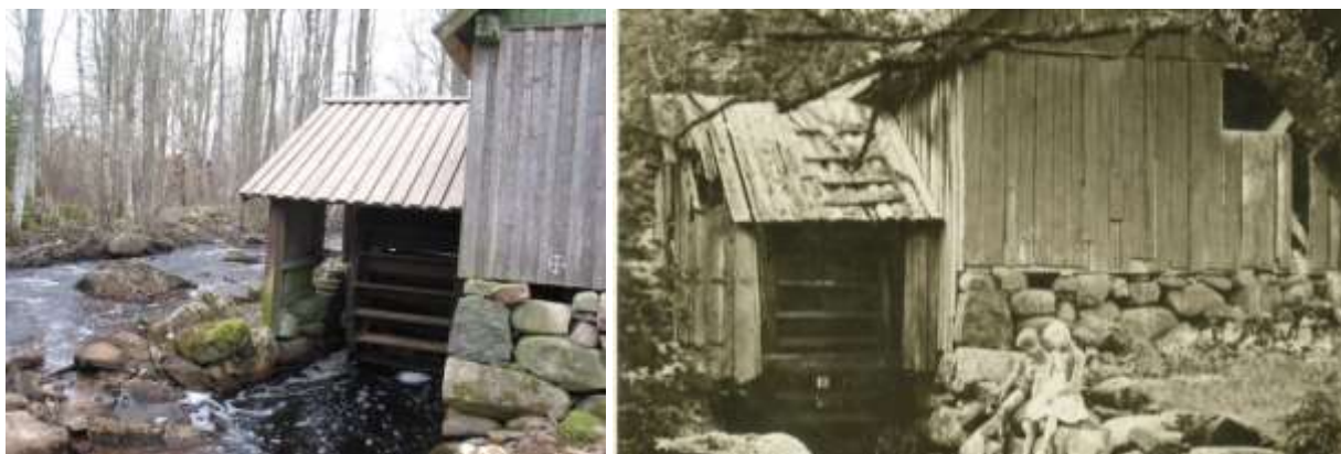
Den unika sten/degel-krossen med glasrikets enda (rekonstruerade) vattenhjul som har direkt med glastillverkning att göra. Till vänster från 2012, till höger från 1940-talet. (Förlångskvarn 1:85).
