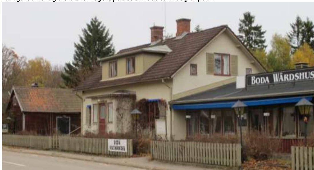
Intill den fd brukshandeln, under en period Boda wärdshus (Förlångskvarn 1:143), finns också ett uthus bevarat. Detta var tidigare affärens varumagasin, som under en period innehöll frysack åt brukets anställda.
