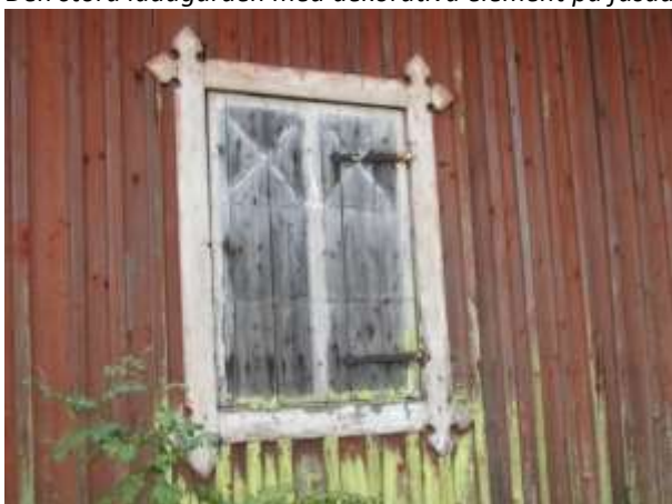
Ett av de många blindfönster som finns på ladugården. imponerande
