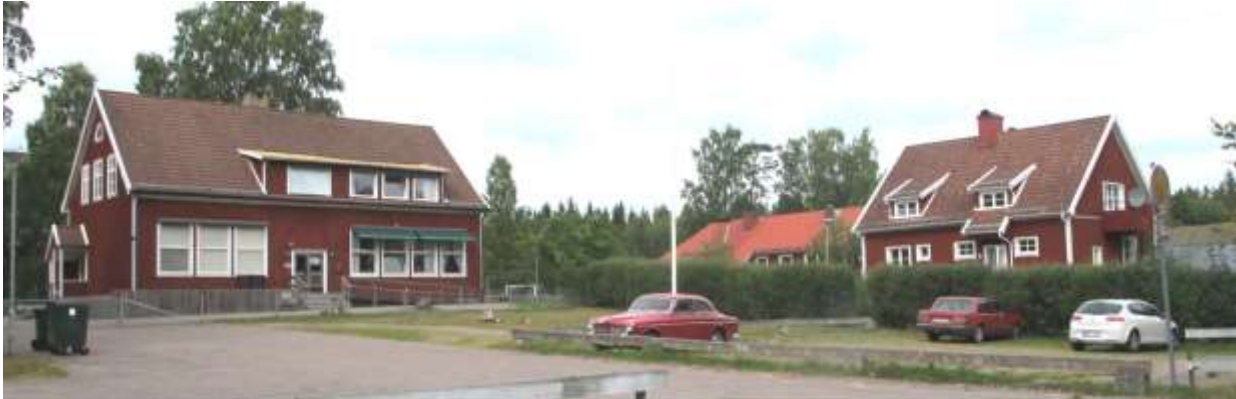
Eriksmåla skolmiljö med tidstypisk skolbyggnad, lärarbostad och gymnastikbyggnad. (Långelycke 1:53 och 1:69)
