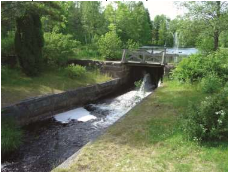
Stensatta vattentrännor, dammluckor och dammvallar i Johansfors vid glasbruket. Här låg förr stora sliperibyggnader.
