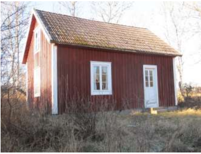
En välbevarad liten äldre typ av undantagsstuga, en sk enkelstuga med originalfönster, dörr, panel mm (Moshultamåla 1:29). Gamle skolmästaren Elias Stark har bott här.
