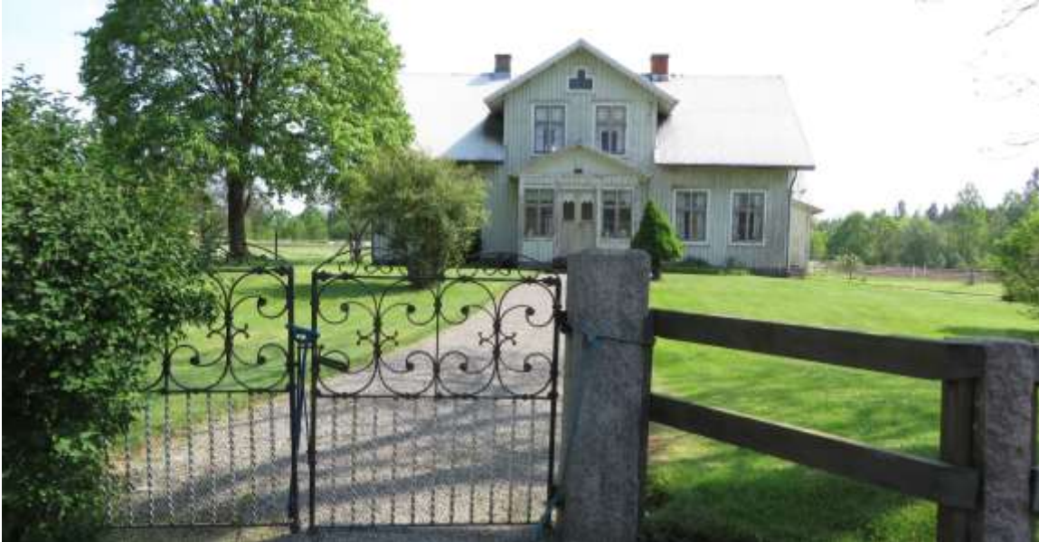
Södra gården (Allgunås 3:3) med ett ovanligt välbevarat bostadshus från sent 1800-tal. Det är en s.k. salsbyggand med litet karaktäristiskt fönster i gavelspetsen. Det kulturhistoriska värdet är högt.
