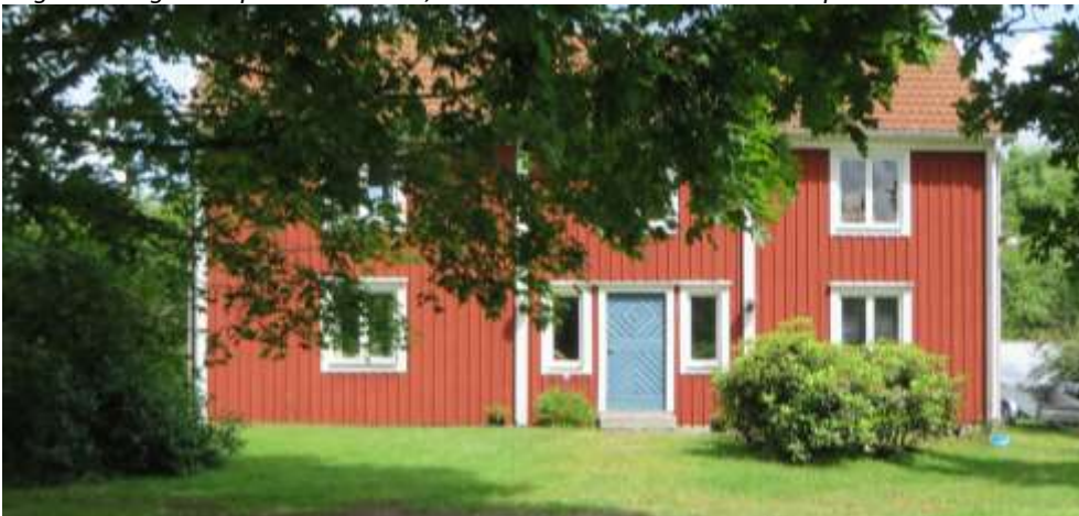
Denna gård centralt i norra delen av byn är idag frånstyckad (Allgunås 2:18) och utan ladugård. Bostadshuset är en rödmålad traditionell parstuga i två våningar, som genomgått renoveringar under 1900-talet där delar av originaldetaljerna bytts ut.
