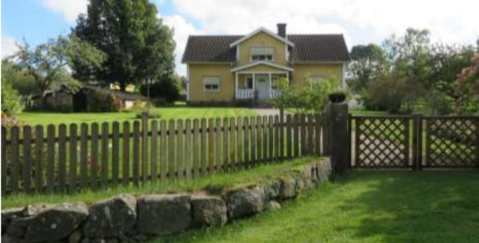
Bostadshuset och staketet har genomgått förändringar men är ändå i grunden en traditionell utskiftad gård (Allgunås 2:23) från mitten av 1800-talet, med bostadshus av salsbyggnadstyp.
